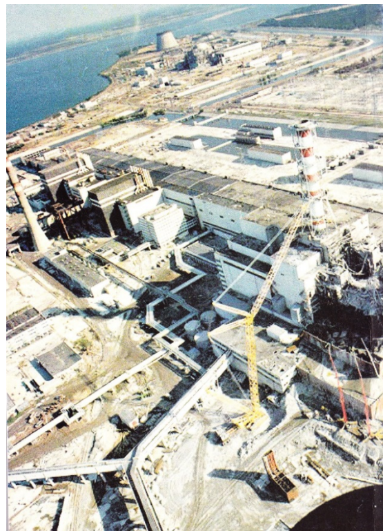
Идет строительство защитной стены на северной стороне
