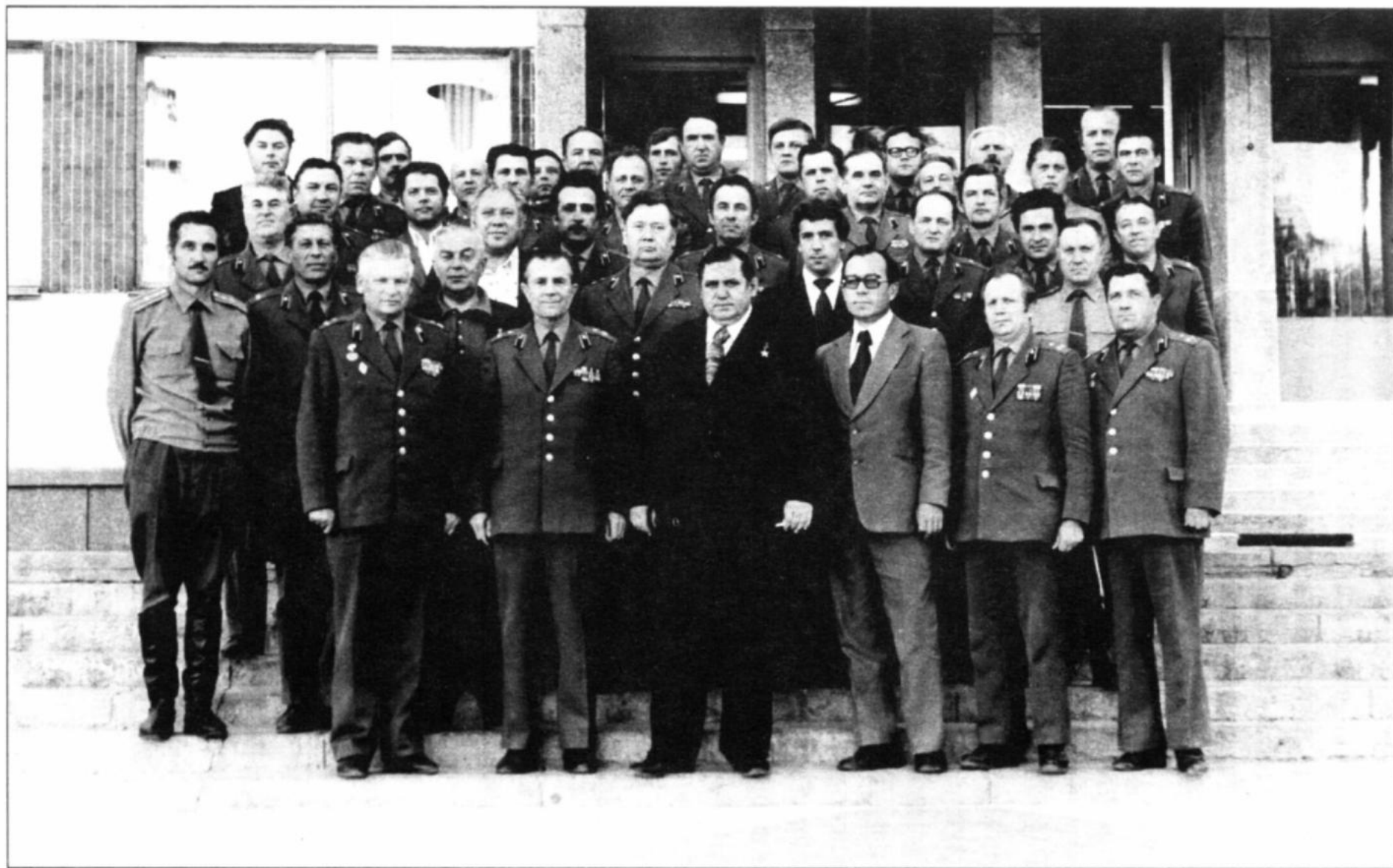
Руководство Северного управления строительства и командование военно - строительных частей. В центре начальник СУС Герой Социалистического труда Семькин И.И. (июль 1978 г.)
